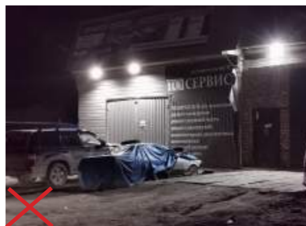
Недопустимо устанавливать светильники (прожекторы) со слепящим эффектом.
